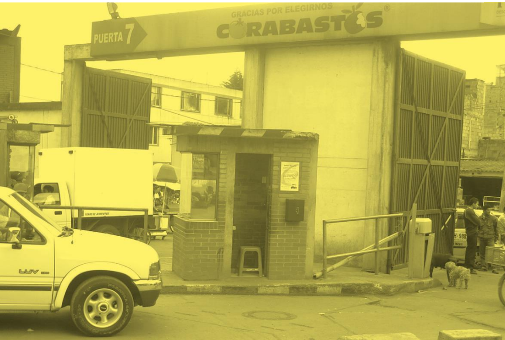
Antes de la construcción de las Vías (2007)
