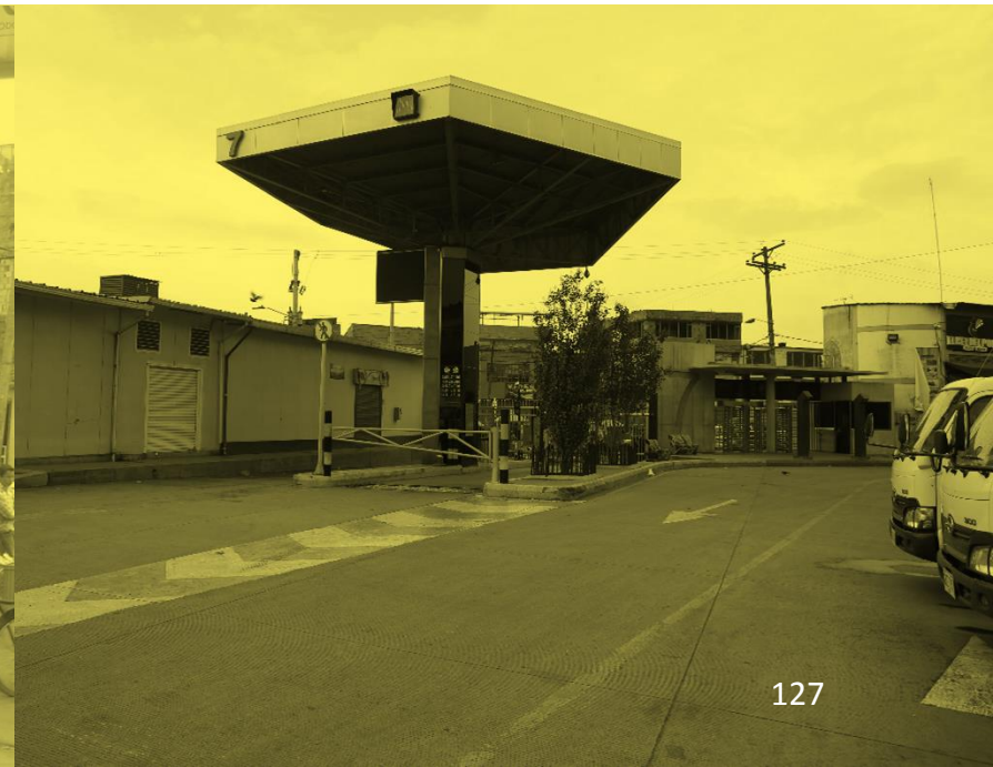
Después de las obras construidas (2020)
